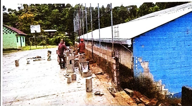
Foto 4: Ampliación del muro perimetral que cubre el primer módulo
