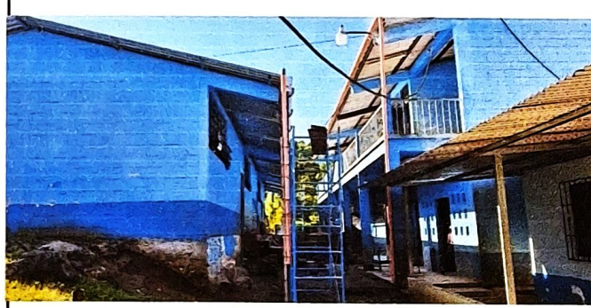
Foto 6: Instalación de vigas y techo del pasillo del primer módulo
