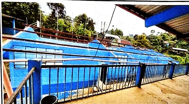
Foto 1: Sustrucción de lamina en mal estado por lamina troquelada en aulas.
