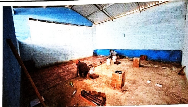
Foto 2: Sustrucción de piso de concreto en mal estado por piso ceramico en aulas
